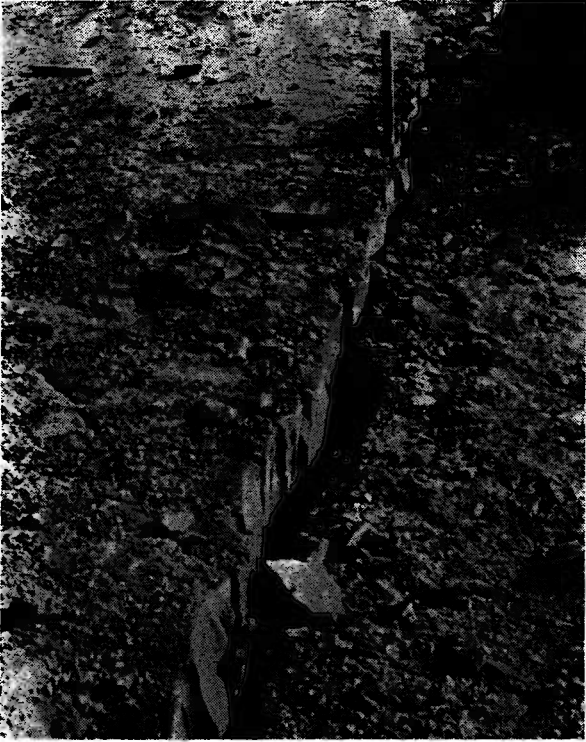
Fig. 13.19 - Effetto di una volata per il taglio preventivo in una massa rocciosa solida, con fori a 60 cm (dallo studio di cui alla nota [13.17])
