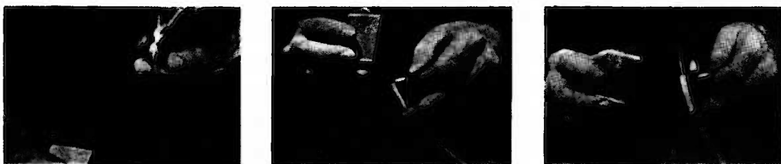
Fig. 10.5 - A sinistra, accensione del fiammifero, con la capocchia nel taglio della miccia (quindi della miccia), fregandovi contro la scatola; al centro, la capocchia del fiammifero appoggiata all'estremità della miccia tagliata netta perpendicolarmente al suo asse; a destra, accensione della capocchia (quindi della miccia) fregandovi contro la scatola (Blasters' Handbook, 15° ed., 1966, Du Pont)
