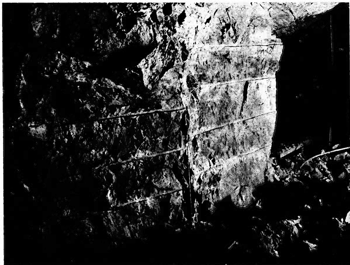
Fig. 16.45 - Parete liscia di galleria ottenuta con il tiro di contorno in una miniera della Climax Molybdenum Company
