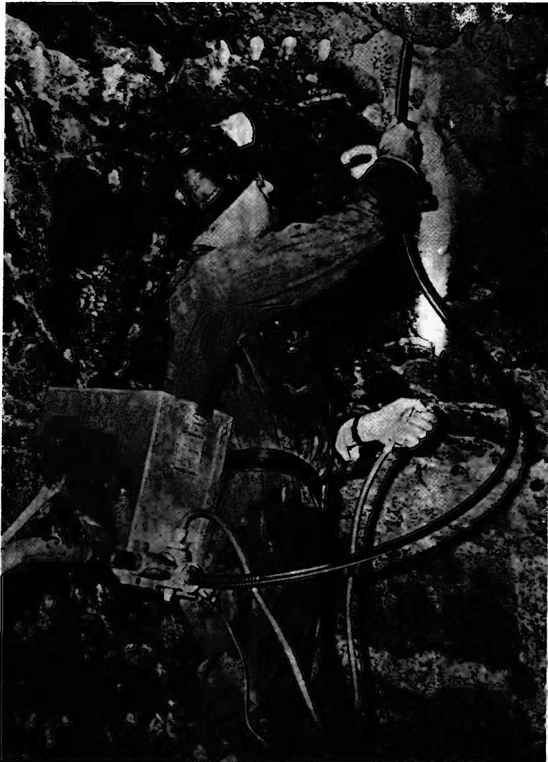
Fig. 8.64 - Caricatrice pneumatica a zaino Anoloder 2B50 (Penberthy)
