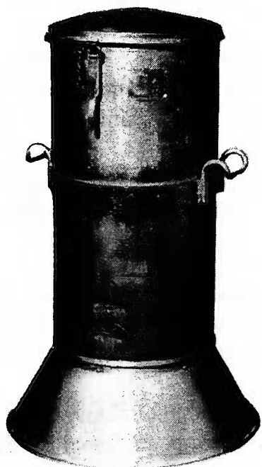
Fig. 8.74 - Recipiente per la imbibizione delle cartucce con ossigeno liquido, di capacità 60 litri, sufficiente per sessanta cartucce (Socoxyl, Briay; foto P. Winckel, Audun - le Tiche, Francia)
