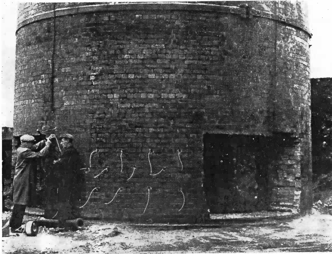
Fig. 17.28 - Caricamento dei fori per demolire una ciminiera dopo avere creato dei pilastri con l'apertura preventiva di finestre (Blasting Practice, 3.a ed., 1962, Imp. Chem. Industries)
