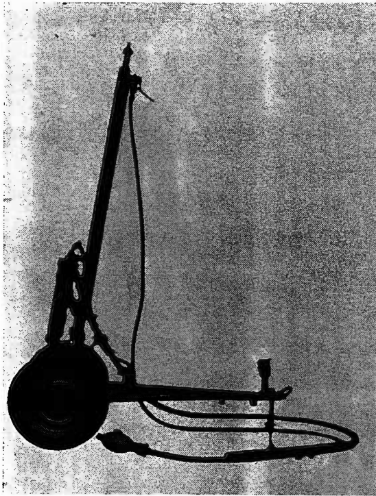
Fig. 5.4 (a sinistra) - Sbancatore per perforatrici pesanti fino a 30 kg, impiegabile con aste estensibili per profondità fino a 10 m (Atlas Copco; servizi fotografici Costa, Milano)
