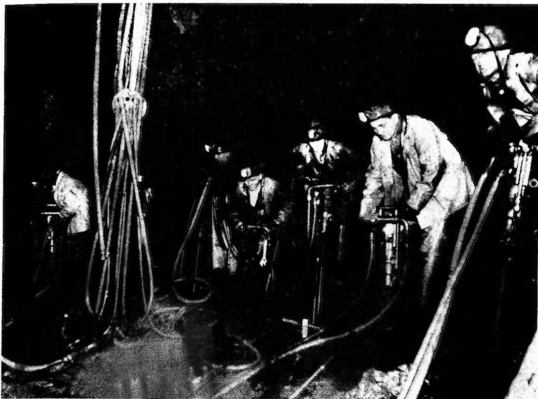
Fig. 5.3 - Perforazione con martelli a mano nell'approfondimento del pozzo della miniera Creighton, della International Nickel Company, Canada; il pozzo risulterà profondo 2 180 m
