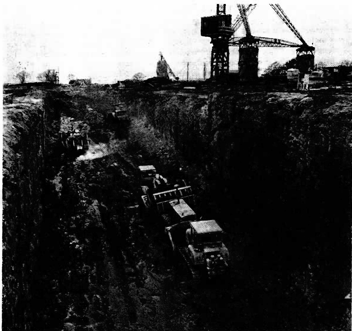
Fig. 13.22 - Pareti di uno scavo ottenute con il taglio preventivo a Longannet (Scozia)
