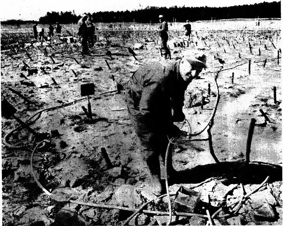
Fig. 16.21 - Apertura del canale di Lindö, in Svezia: caricamento di una volata di 4 763 fori (dal fascicolo « Lindö Canal », Skånska Cementgjuteriet, Stoccolma)
