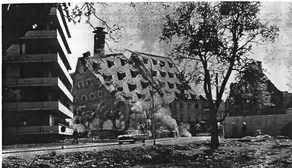
Fig. 17.26 - L'abbattimento della prima metà dell'edificio di cui a fig. 17.24 (Nobel Hefte)
